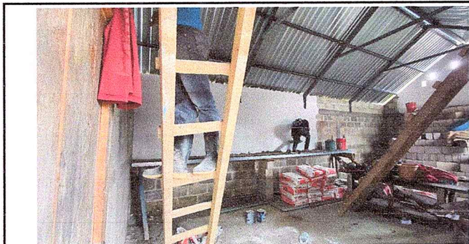
Foto 1: Se realizó el cambio de entechado, y así mismo se puede observar la aplicación de monocapa en las paredes de la cocina.
