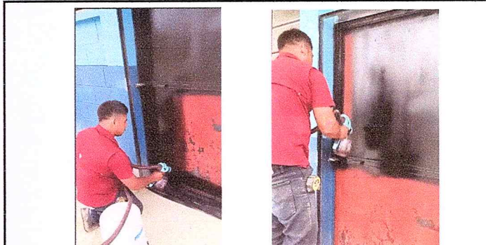
Foto 2: Se realiza el mantenimiento a las puertas de todo el edificio escolar, para una mejor visibilidad.
